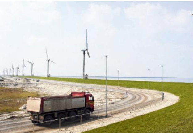
Met de klok mee: de zeesluizen bij IJmuiden; stuw- en sluizencomplex Hagestein in de Lek bij de voltooiing in 1970; de Beatrixhaven in de Eemshaven in Groningen bij de opening in 2008 FOTO'S ANP
